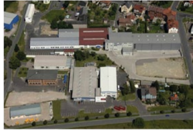
Betriebsgelände der Feintechnik in Eisfeld
